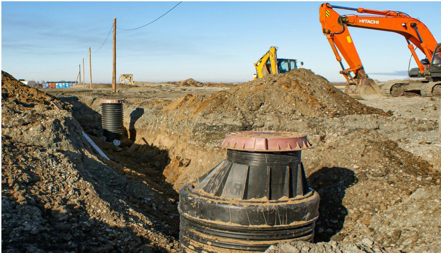
Канализационные колодцы в соответствии с СП.32.13330.2012 применяются для инспекции и обслуживания сетей канализации (как напорной, так и безнапорной) в зависимости от типа и назначения канализационных сетей.
